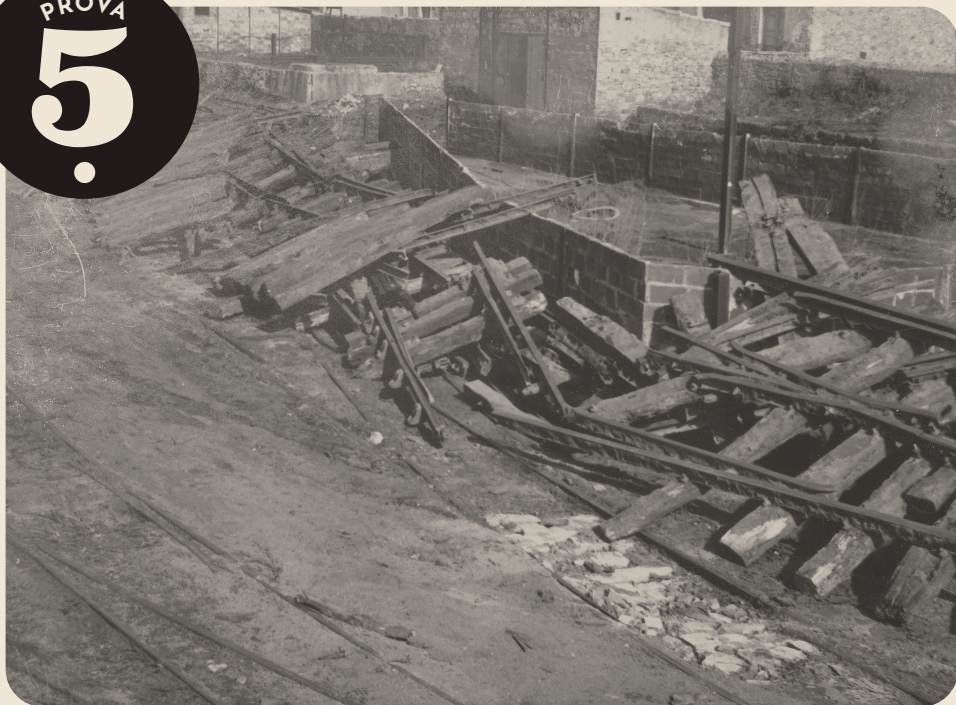
Desmantellament de vies i travessers del Tren Petit, [1957-1960].
