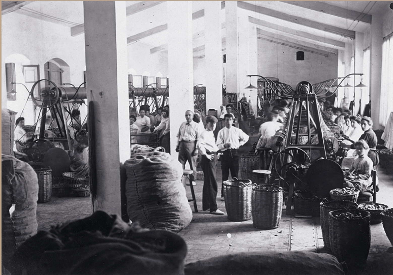
Sala de màquines d'esmeril de les fàbriques Montaner SAMP. Fons R. Palet
